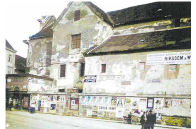
Klosterkirche. Noch nach 1900 war beim desolaten Monturdepot auf der Nordseite die ehemalige Klosterkirche der Karmelitinnen zu erkennen.
