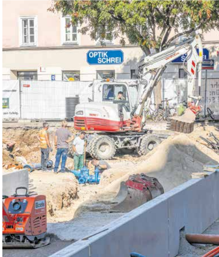
Für die Neutorlinie. Bei den Bauarbeiten geht's voran.
