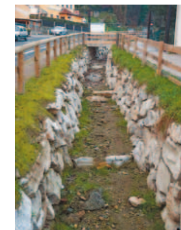
Einödbach: Unterlauf ist fertig.
