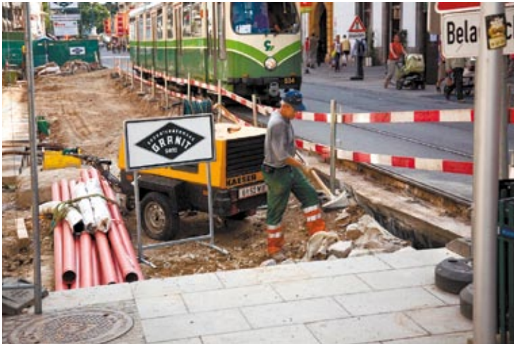
Herrengasse: Neuer Granit ersetzt alte Stainzerplatten.
